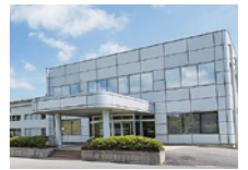
石川工場/ 石川県羽咋郡志賀町
