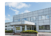
石川工場／ 石川県羽咋郡志賀町
