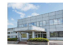
石川工場 / 石川県羽咋郡志賀町
